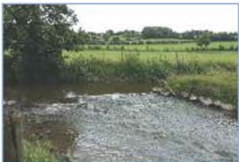
Travaux de restauration de la continuité du cours d'eau, abaissement de seuil.
