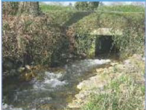
Suppression d'obstacles : rampe d'enrochement.
